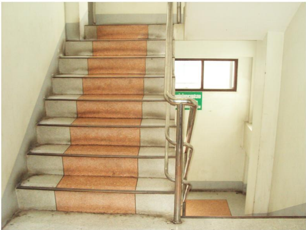
บันไดขึ้น-ลงอาคาร
